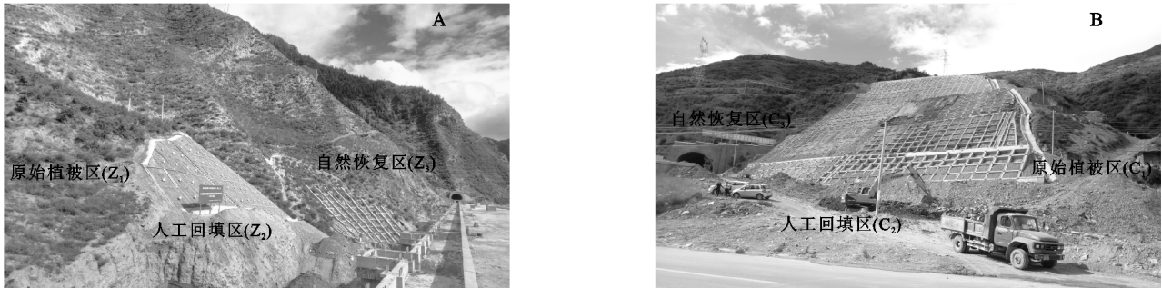
图 1 成兰铁路镇江关(A)和川主寺(B)受损边坡植被恢复分区
