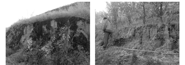
图6 老梯田田埂表皮结皮脱落(郭晋伟于2017年10月拍摄)
