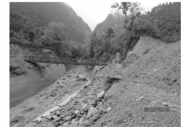
图 2 比通沟泥石流跃上钢桥淤埋公路
