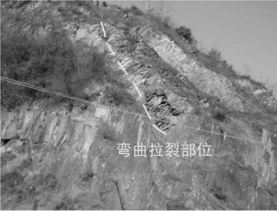
图 7 弯曲- 倾倒变形破坏模式
