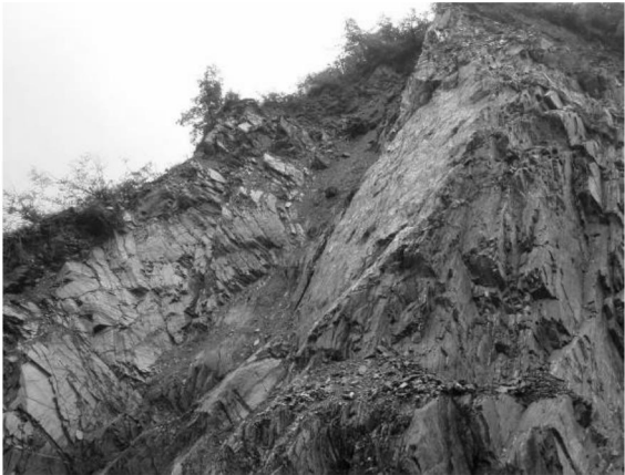
图 8 楔形体滑动变形破坏模式
