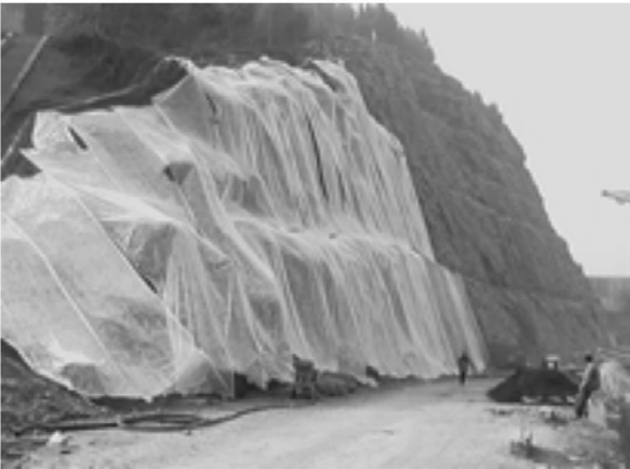
图 14 无纺布用于喷射护坡绿化技术中
