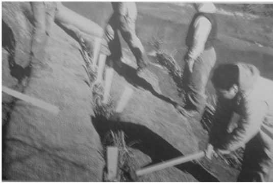
图 9 活枝捆垛与土工网配合用于河岸防护
