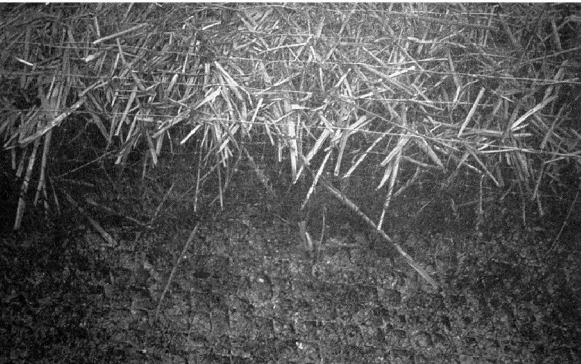
图 15 稻草帘覆盖喷射边坡
