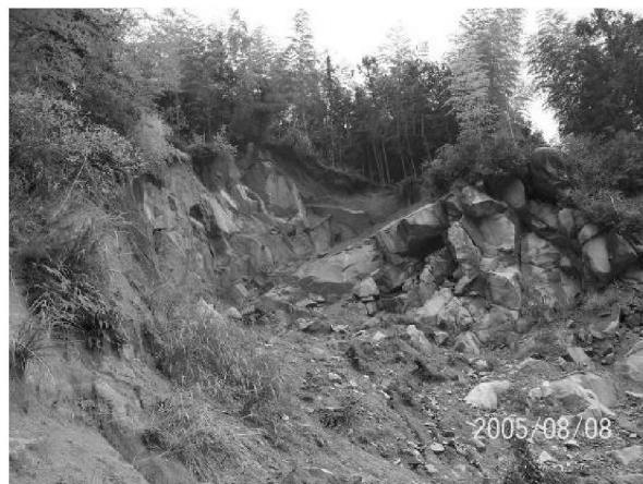
图 3 A2 区边坡破坏情况
