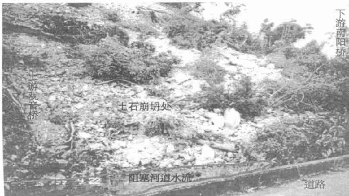
图2 旱溪走山致南阳、北阳堤防受损及河道阻塞情况
