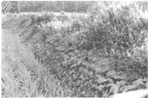
图 9 干砌石护坡工法
