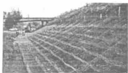
图3 施工中的铁丝网与碎石种植基
