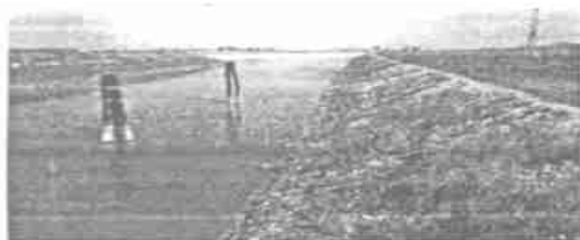
图3 施工中的铁丝网与碎石种植基
