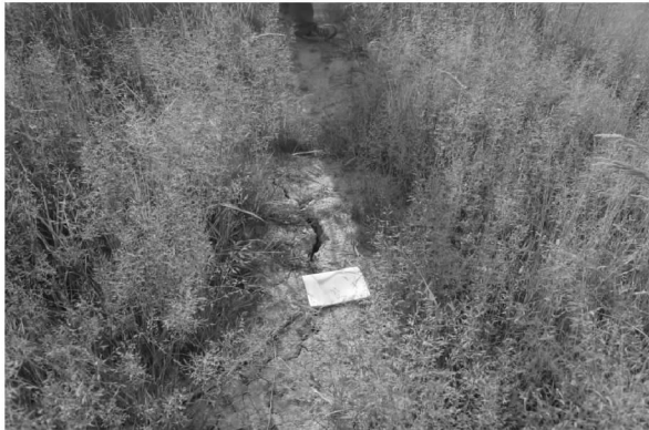
图 4 第二级台阶上的裂缝
