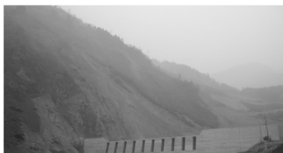
图3 红椿沟两岸坡体大面积失稳
