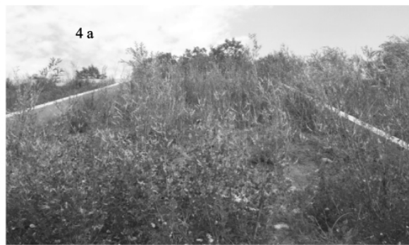
图 2 北京市开发建设项目水土保持试验示范基地码石扦插柳干护坡
