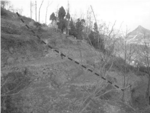
图 6 滑坡后侧缘堡坎线状倒塌反映出的滑面形态及复活特征
