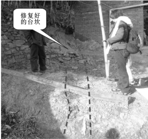
图 4 地震引起的片石台坎破坏和地表裂缝
