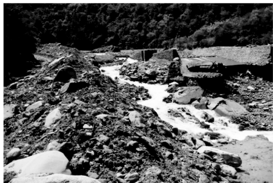
图 12 泥石流冲毁拦水闸
