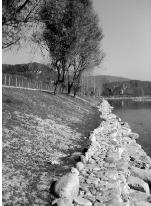
图 3 一渡河段抛石+ 植物护岸
