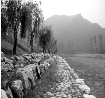
图 4 四渡河段浆砌石+ 大块石+ 植物护岸
