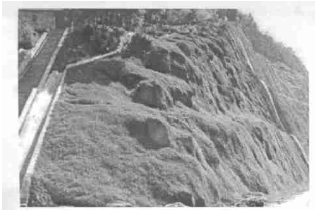
图 1 高坝州水利枢纽王家冲高边坡防护绿化工程( 右边正在施工)
